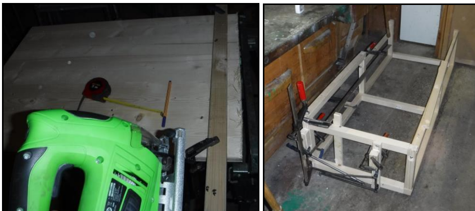
Links: Platten zuschneiden
